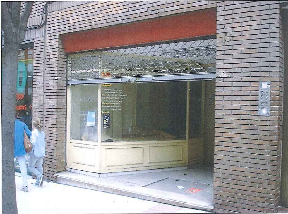
Detalle zona de acceso
