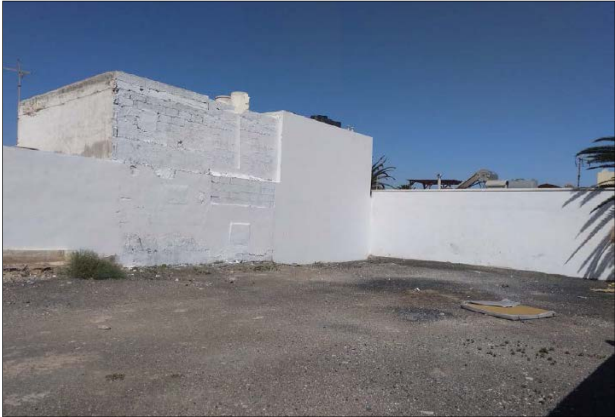
Interior - Vista fachada fondo y lateral derecha
