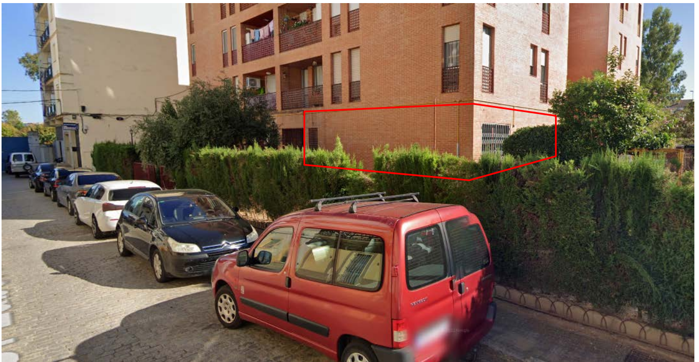
Fachada lateral a calle Alejandro Laborde – Una ventana
