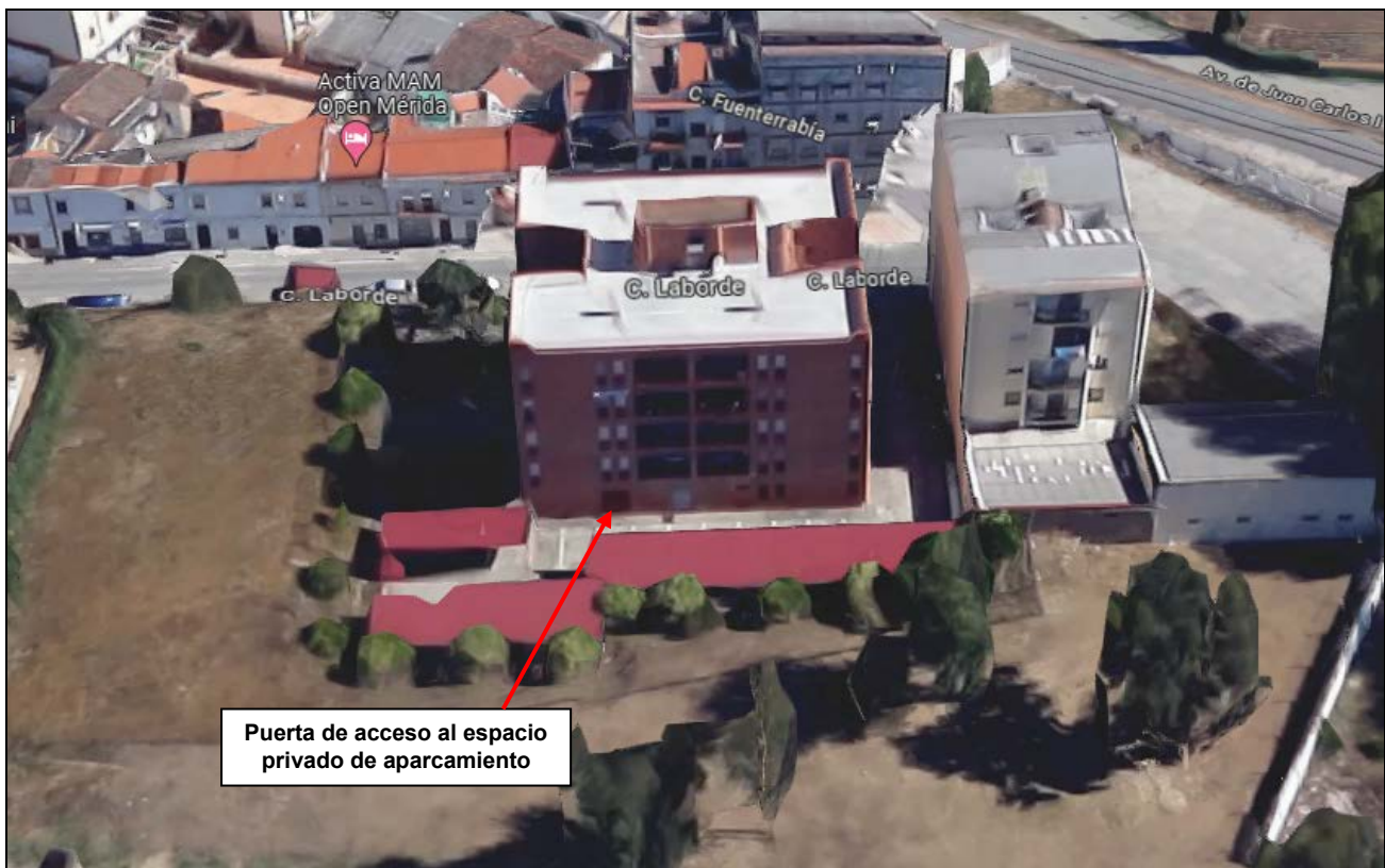
Fachada a zona de aparcamiento del conjunto
