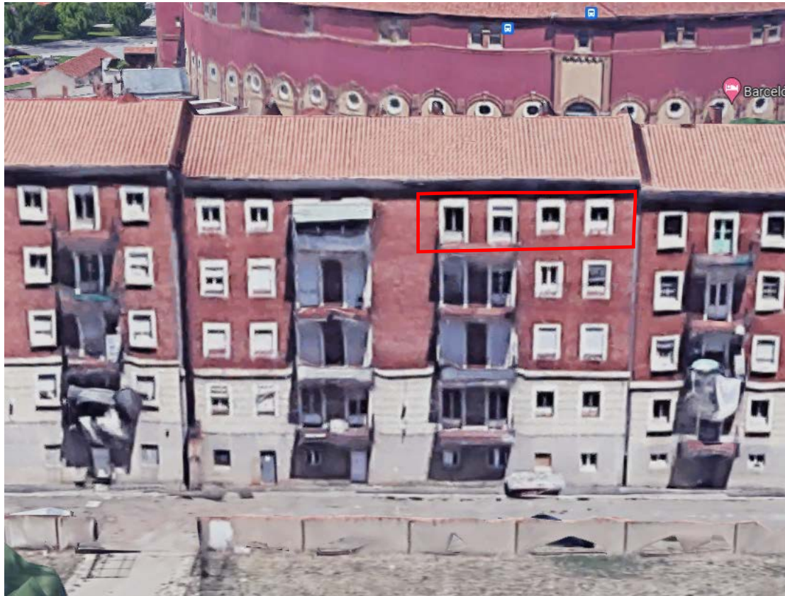
Fachada posterior con dos ventanas y terraza con acceso desde dos dormitorios
