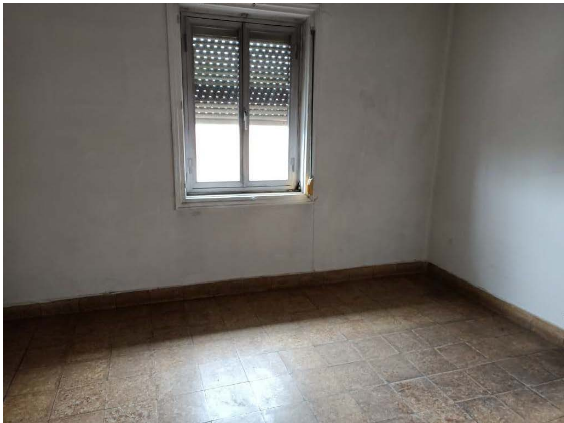
Salón (Ventana a fachada principal)
