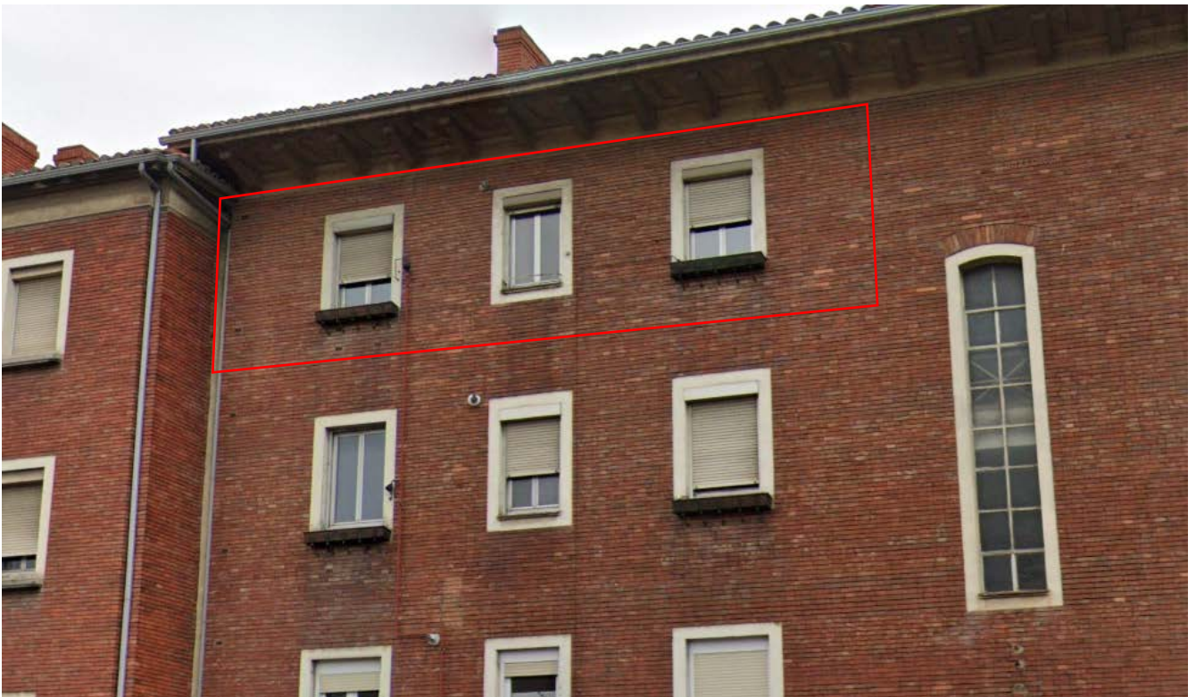
Detalle fachada principal de la vivienda – Tres ventanas
