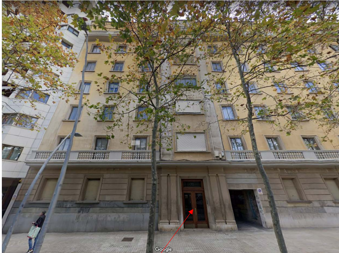
Vista de la puerta de acceso al edificio nº 7
