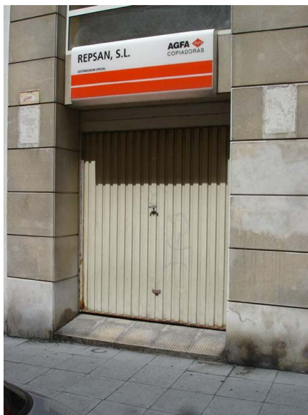
Puerta acceso de vehículos
