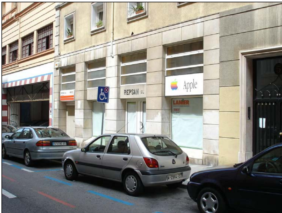
Fachada con puertas de acceso a calle San José
