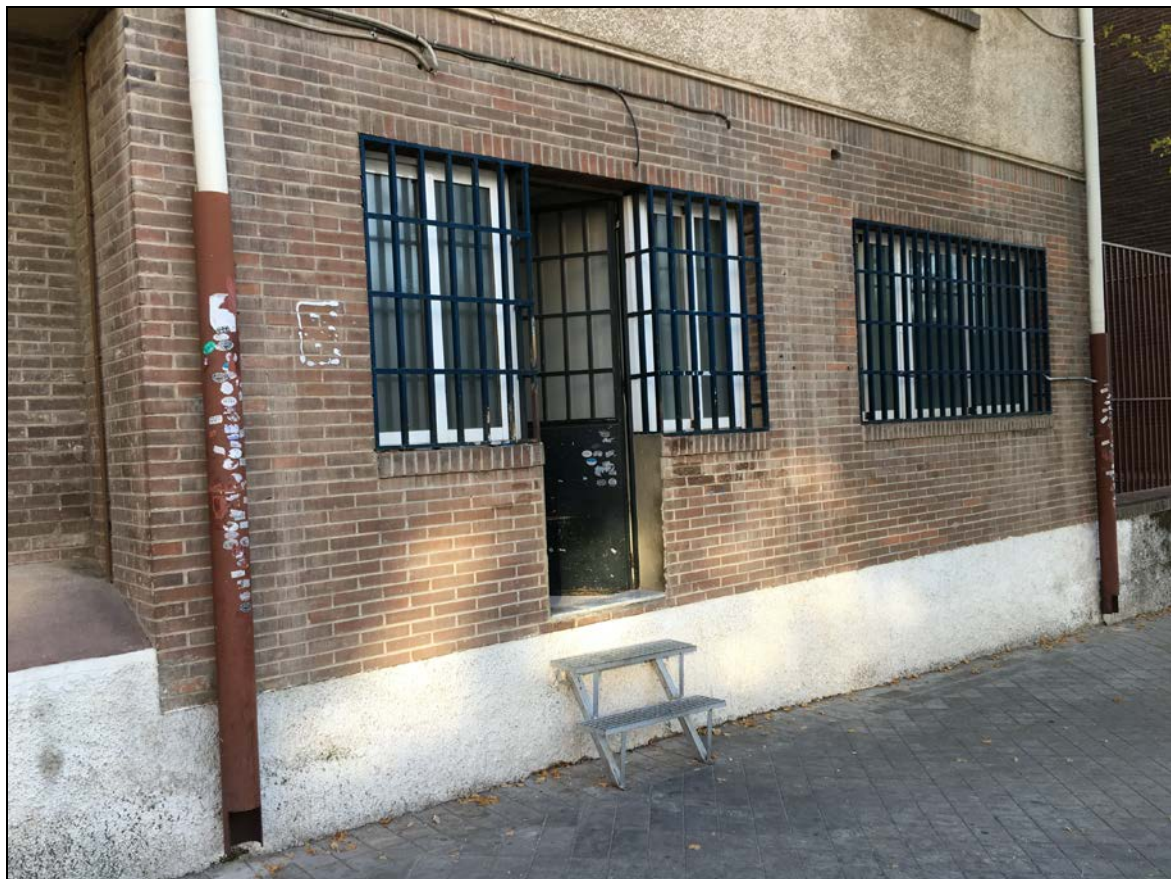
Detalle de fachada y puerta de acceso trasera por la calle Belmonte
