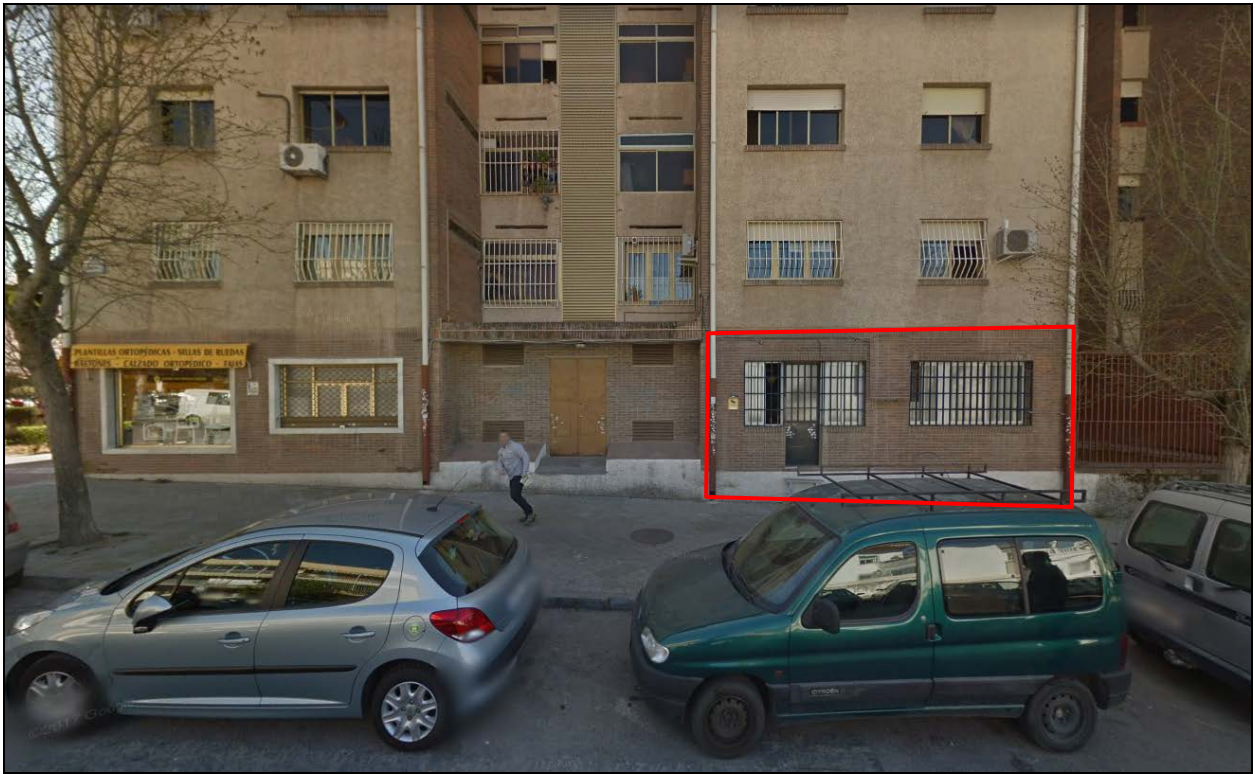
Vista de la fachada y puerta de acceso trasera por la calle Belmonte
