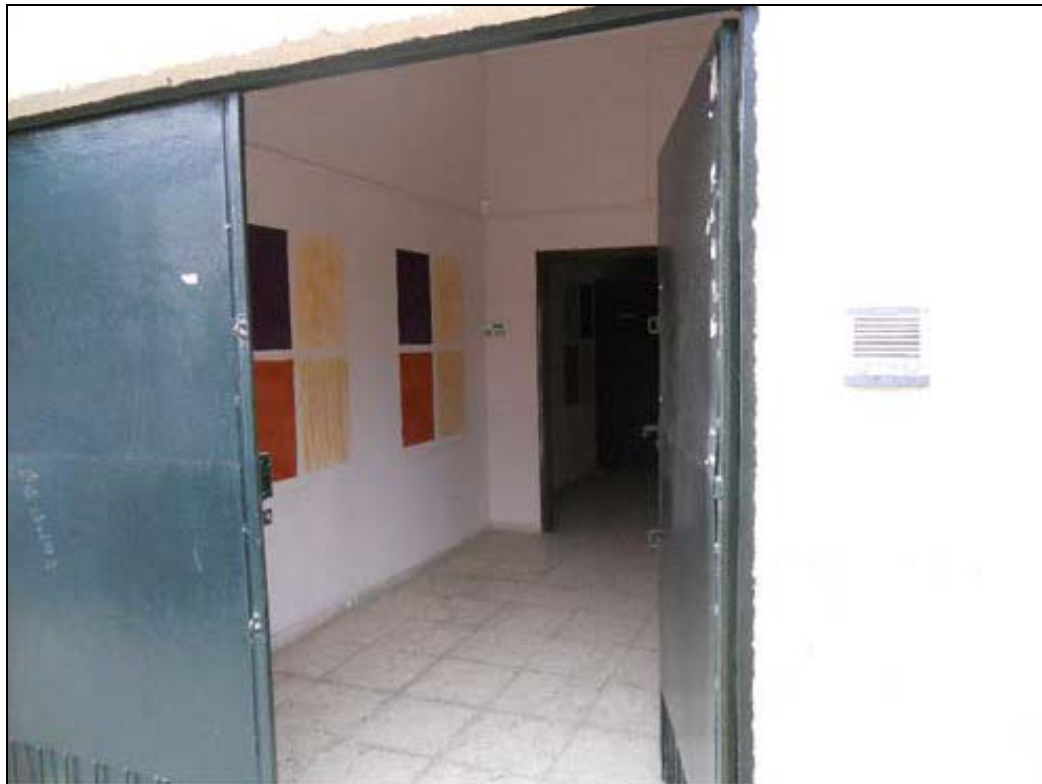
Puerta de acceso y pasillo
