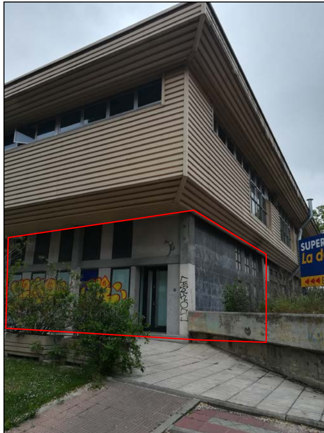
Vista fachadas principal y derecha entrando
