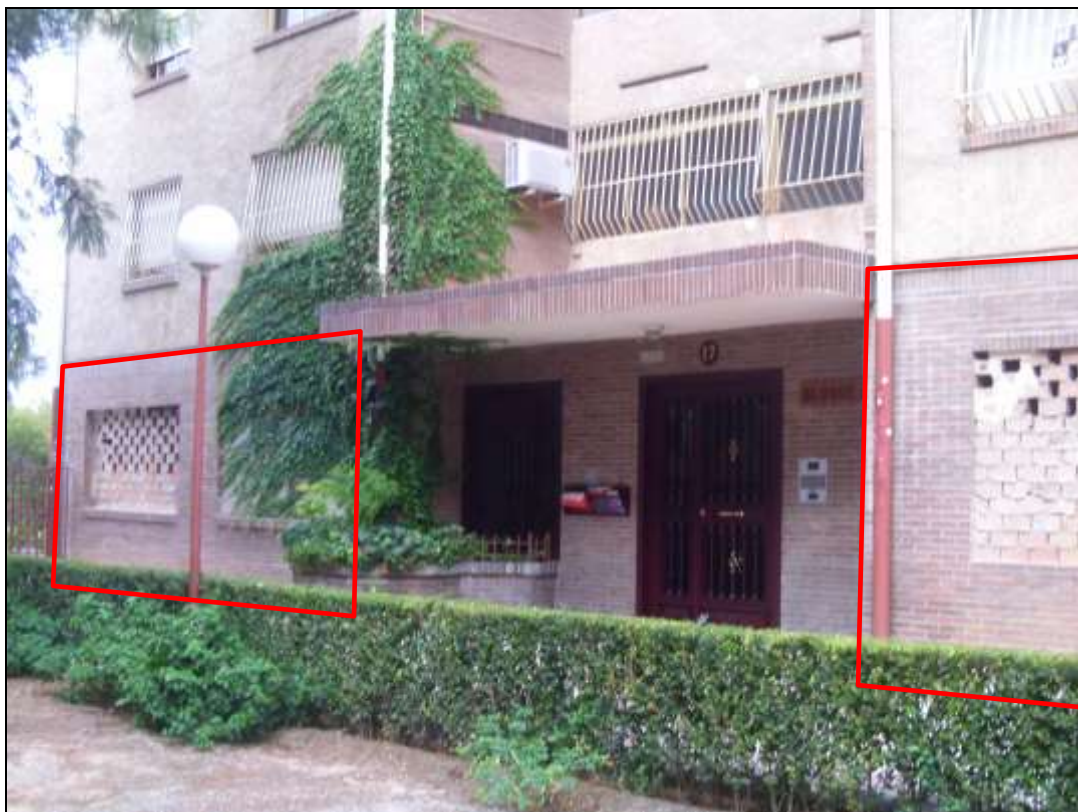
Acceso al portal y fachada a zona de uso privativo
