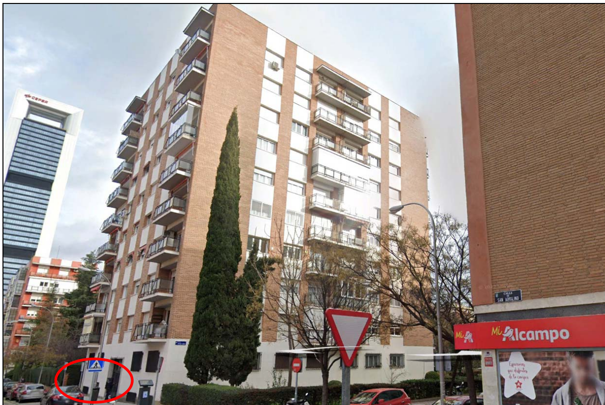
Imagen (Fuente: Google Street View) del edificio tomada desde la calle San Aquilino, esquina calle Matilde Landa. El círculo rojo indica la posición del local en el edificio.
