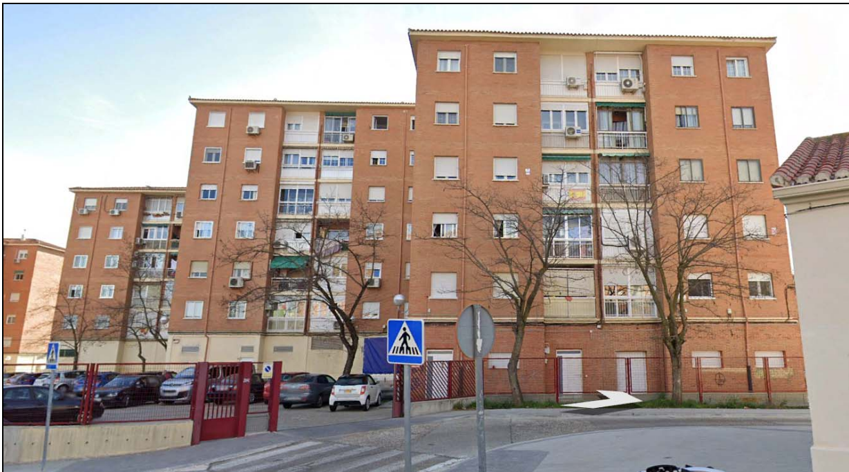
Imagen (Fuente: Google Street View) de la pieza edificatoria desde la confluencia entre las calles Gando y Sania Ramel. El local objeto de este informe puede identificarse por el color amarillo de su pintora, en el nivel de planta baja de los edificios 5 y 7.
