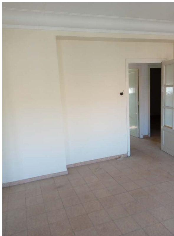
Puerta acceso al salón desde distribuidor)
