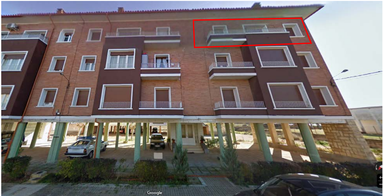
Vista del portal nº 11 (Fachada principal)
