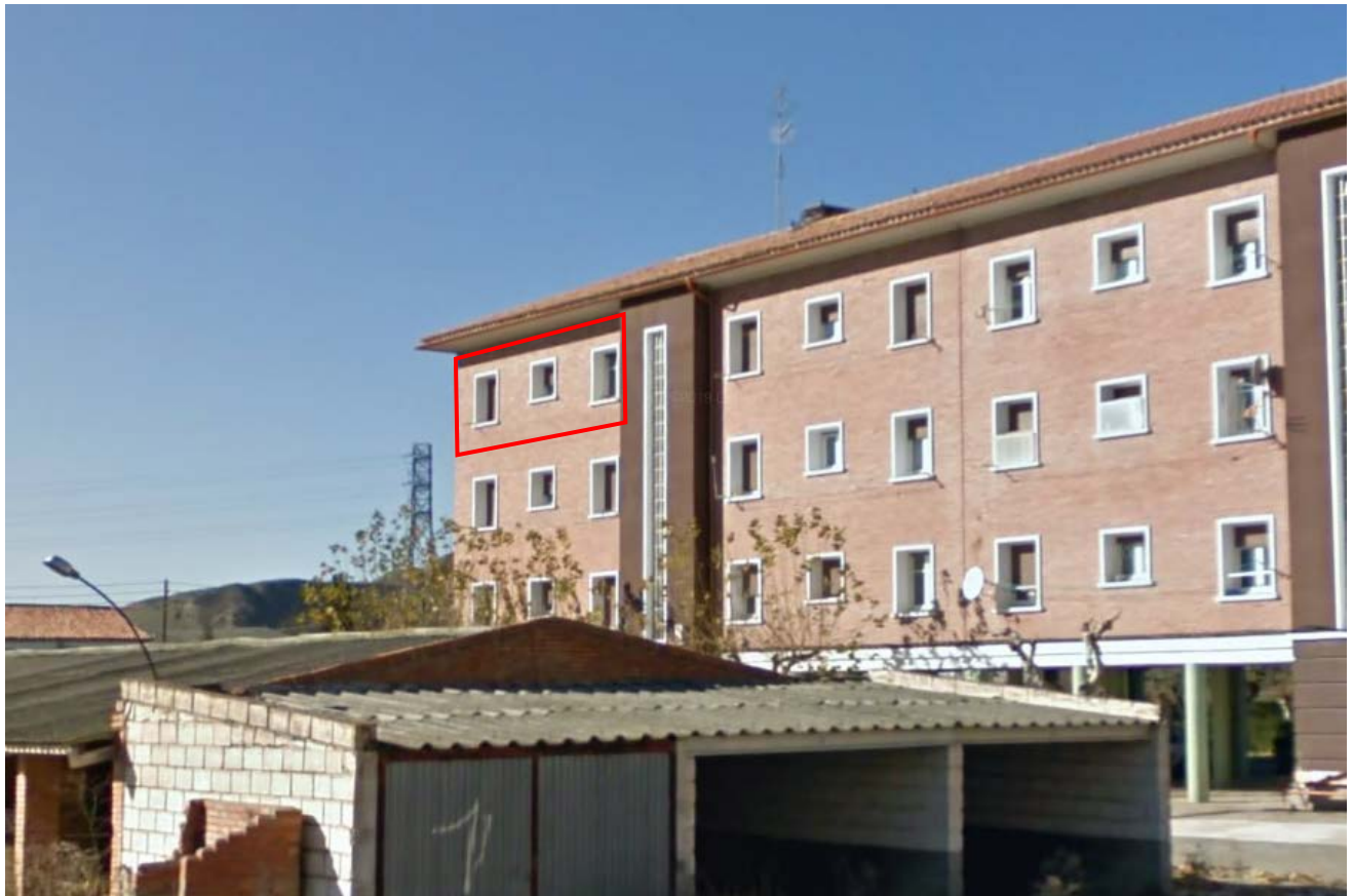
Vista de la fachada posterior – Tres ventanas
