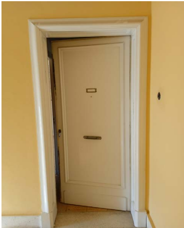
Puerta acceso a la vivienda
