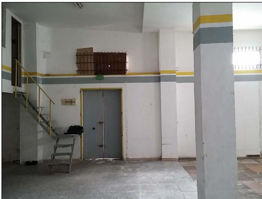
Puerta de acceso desde el interior y escalera de acceso a entreplanta
